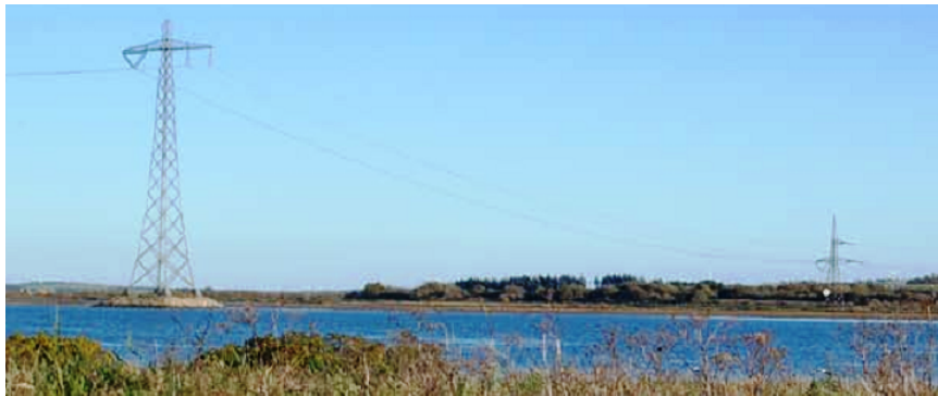
Figur 7.2. Viser samme landskab som figur 7.1, dog er landskabet her visuelt påvirket af et luftledningsanlæg
