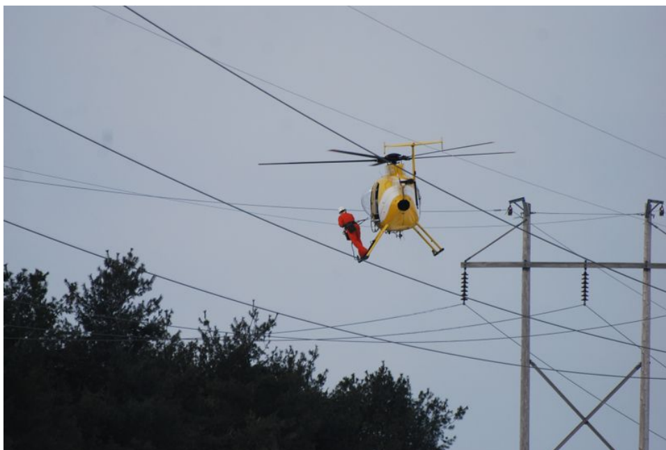
Figur 5.6. Viser en helikopterinspektion af et luftledningsanlæg
